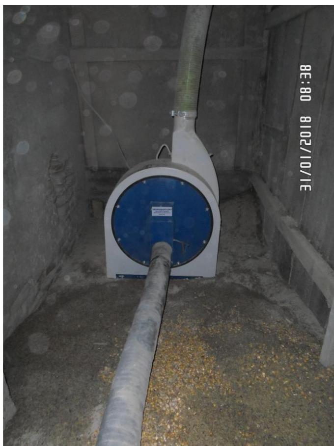
Дробилка пневматическая молотковая ДПМ-18,5
