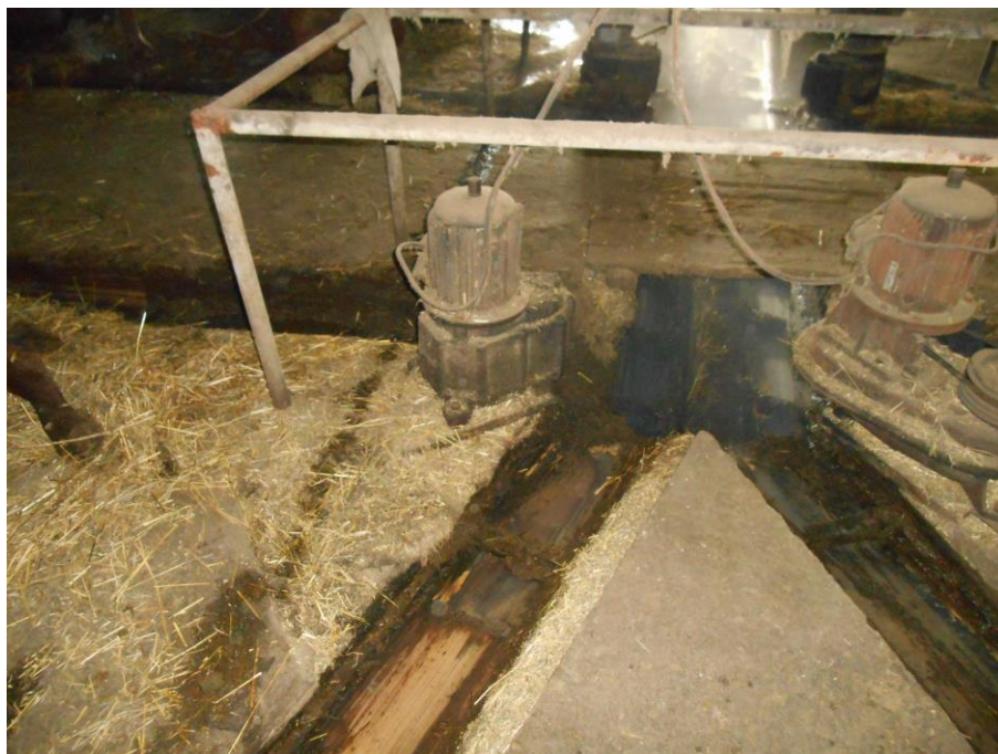
Транспортёр скребковый навозоуборочный ТСН-3,0Б
